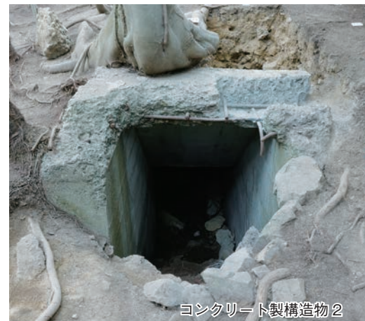
作業状況(防空壕1)
