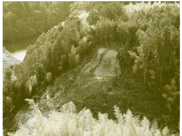
調査区完掘状況 遠景(北より)
