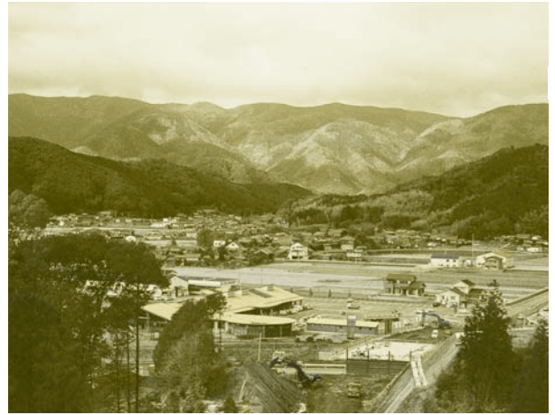
三間盆地をのぞむ(南より)
