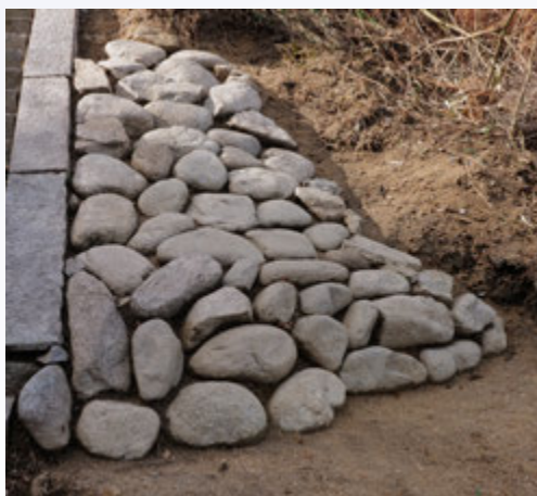
図13 階段1斜面補強石
