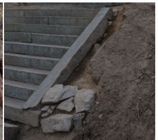
図15 斜面補強石
