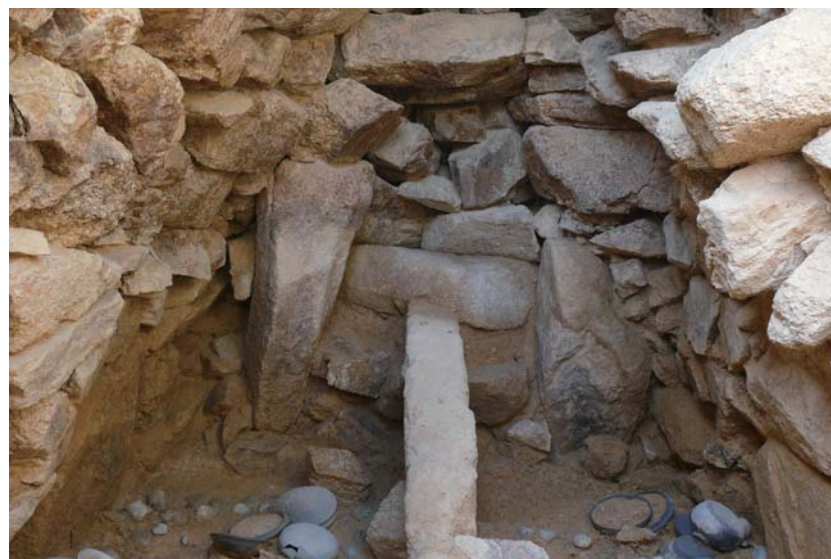
▲外から閉じられた玄門の状況
