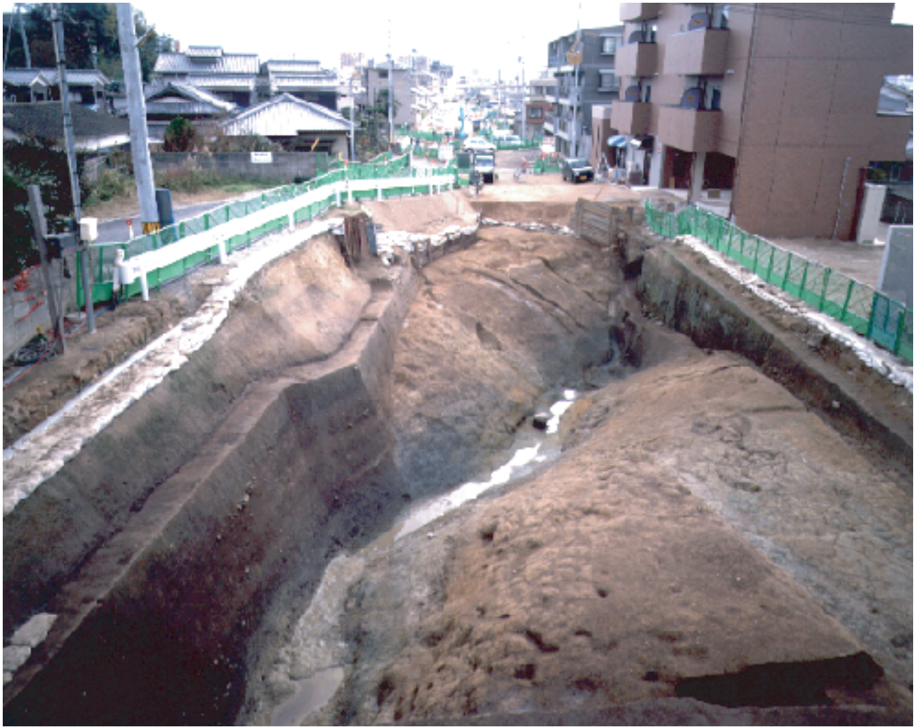
北側から見た大溝
